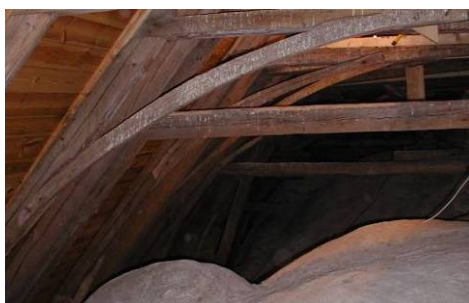
Kyrkan har 25 medeltida takstolar, varav 15 intakta – Digitalfoto Svensk Klimatstyrning AB
