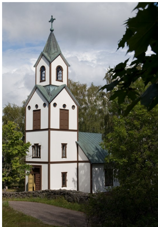
Exteriör från sydväst.
