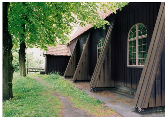
Exteriör från norr.
