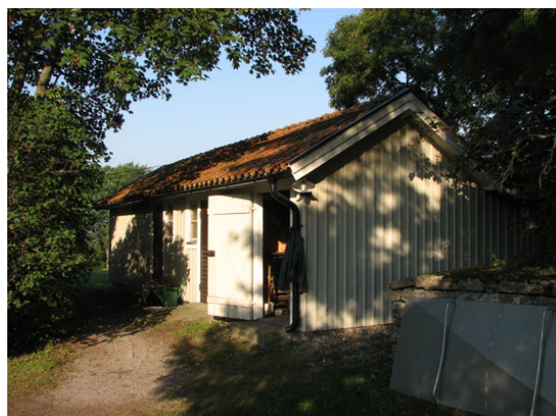
I det nordvästra hörnet ligger en byggnad som inrymmer bland annat personalutrymmen och förråd (KI Gärdslösa kyrkog 017)
