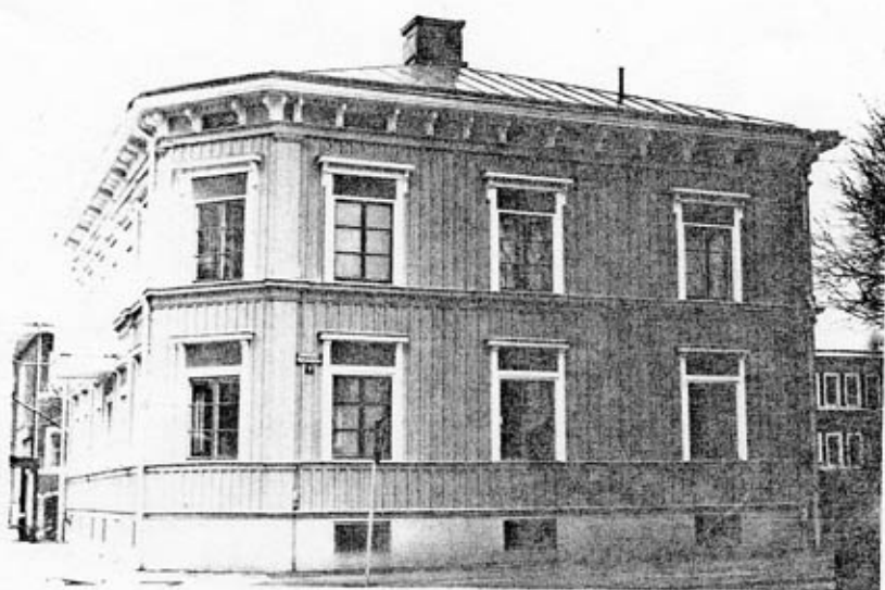
Fasaden mot Nytorngatan K 960:18
