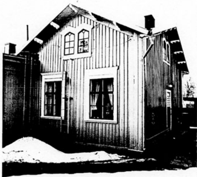
Norra delen av huset från gården i öster
