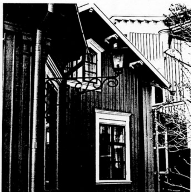
Detalj av utbyggnaden och östfasaden
