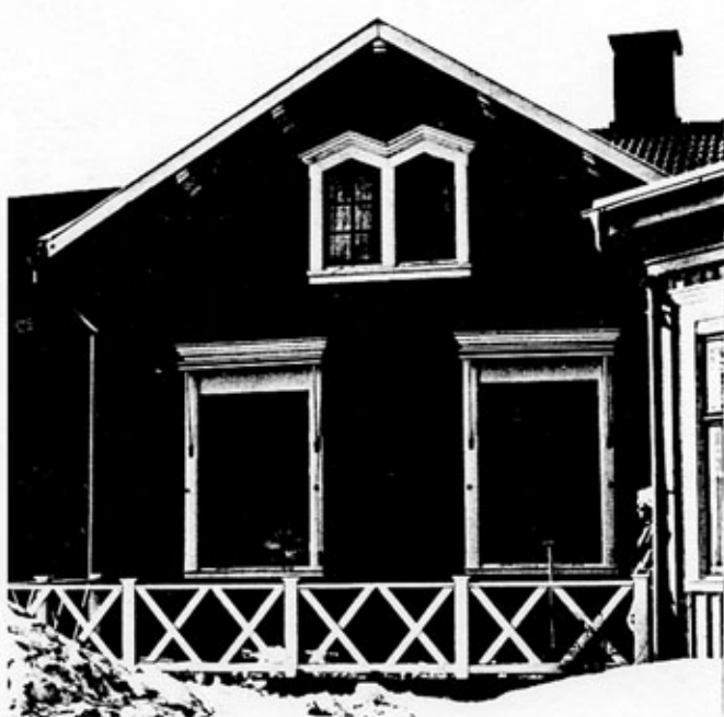
Södra delen av byggnaden mot gården i öster
