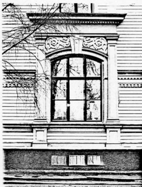
Mittfönster, södra fasaden. C 309:1
