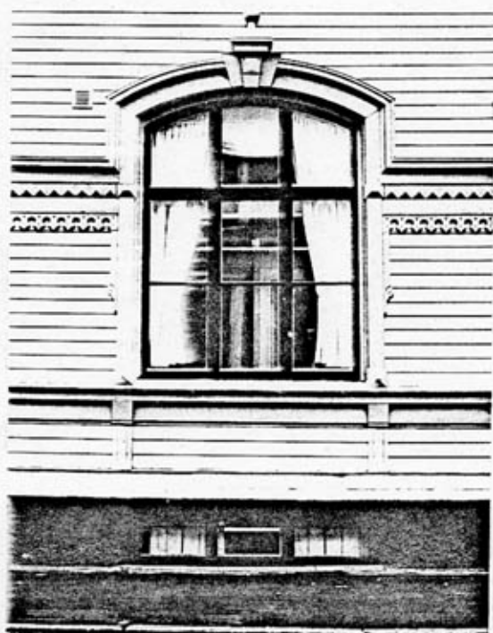
Mittfönster, västra fasaden. C 308:5
