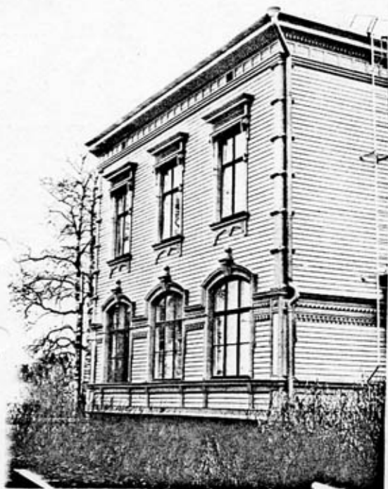
Fasad mot Slöjdaren 2 från Ö. C 308:7
