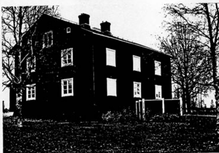
Nr 108, väst- och nord- fasaden (K5194:11)
