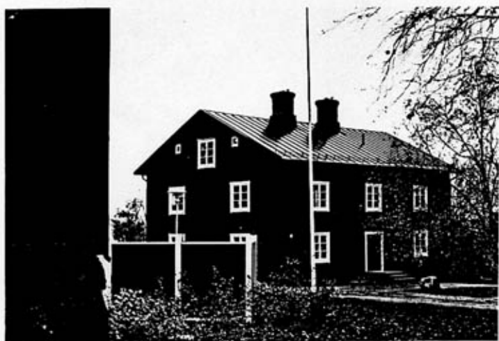
Nr 107, nordfasad och östra gaveln (K5194:10)
