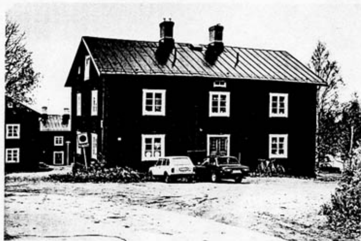
Nr 108, ostfasaden (K5194:17)
