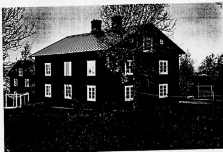
Nr 107, syd- och ost- fasaden (K5194:14)
