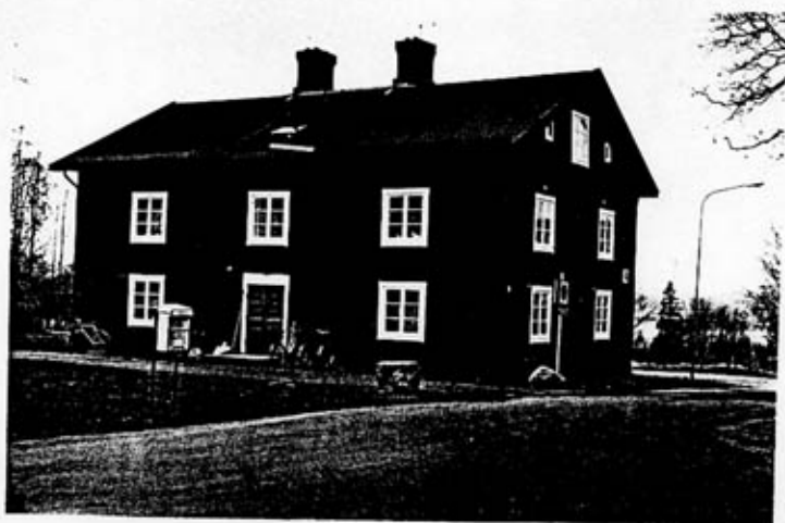
Nr 109, ostfasaden (K5194:23)
