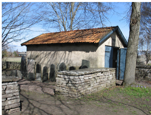
Förrådsbyggnad på nordvästra delen av kyrkogården. (Mörbylånga kyrkog 135)
