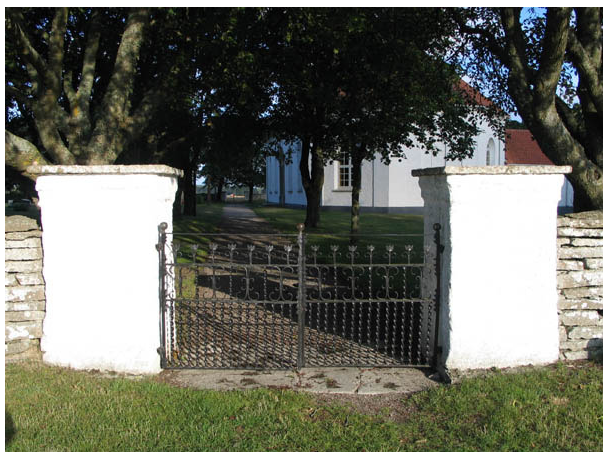
Ingången till kyrkogården i öster. Grindarna är smidda av August Klinth. (KI Sandby kyrkog 001)
