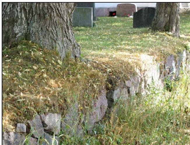
Del av södra muren.
