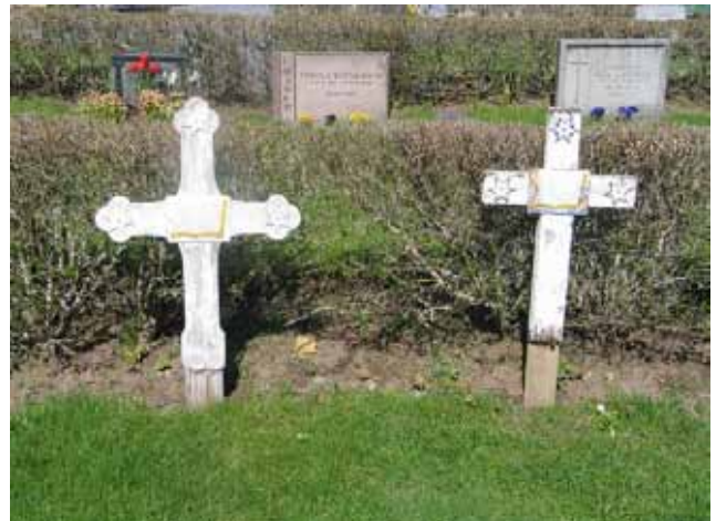
Gravvårdar av trä i kvarter B försedda med emaljskyltar. Notera att de är förlängda. Ett sätt att förlänga trävårdarnas livslängd. (KI Tuna kyrkog 045)
