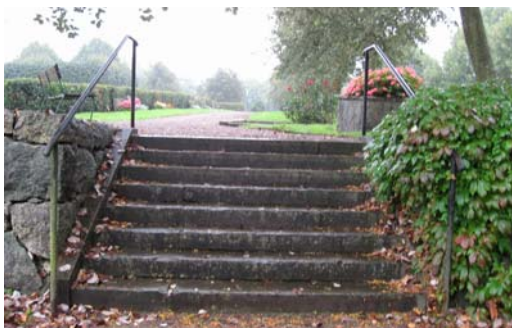
Trappa i den norra muren.
