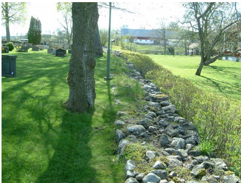
Den nordvästra muren övergår steglöst från fullmur till terrassmur.
