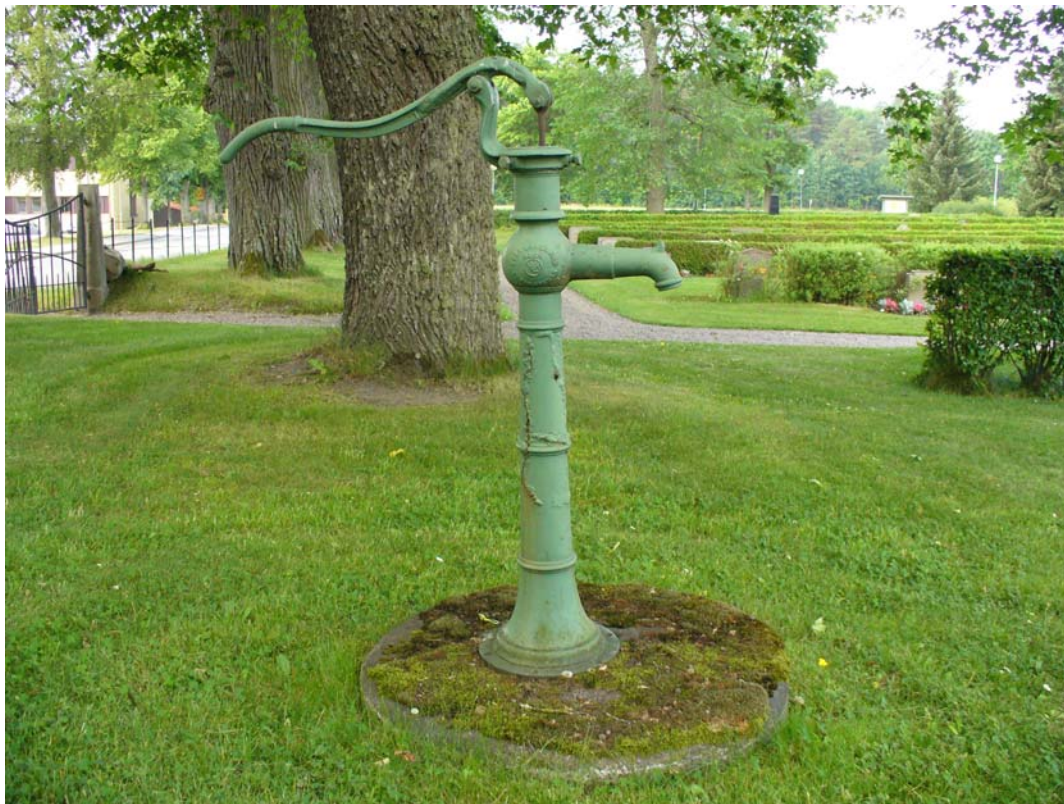
Vattenpumpen står i kvarter B.
