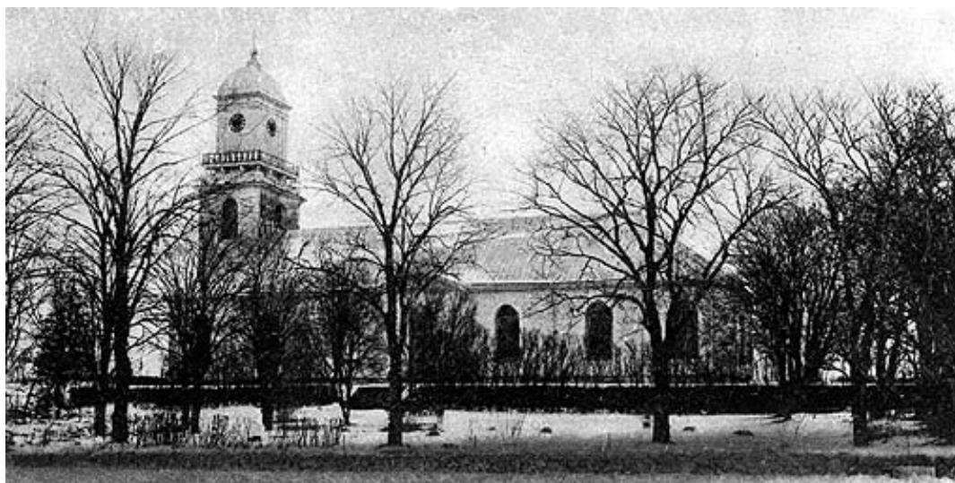
Foto ca 1900. En trädkrans finns runt kyrkogården. Fotografiet visar den höga muren mot kvarter A och kyrkan samt den öppna karaktären i kvarter B. På en stor del av ytan finns det inga gravvårdar. Foto i Östergötlands läns museums samlingar.
