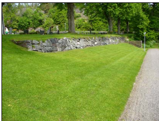
Mur i väster, från sydväst.
