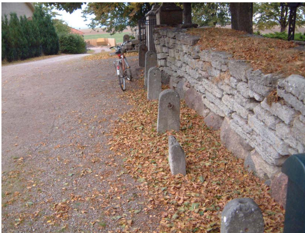
Bindstenar vid västra muren. Foto från söder.
