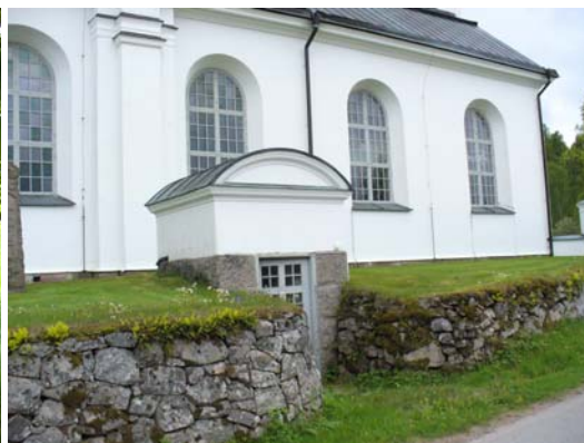
Pannrummet norr om kyrkan.
