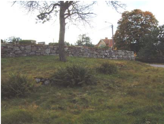
Norra murens västra del.
