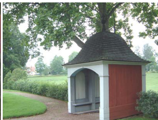
Stigluckan i norr.
