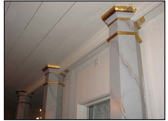
Järnvägsrälsen som bär läktaren har troligen en direkt koppling kring järnvägsdragningen genom Bankeryd 1864.
