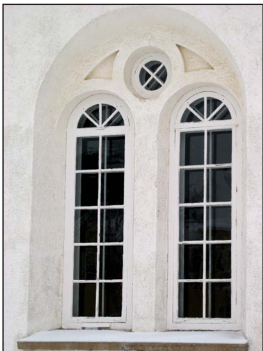
Fönsterbågarna är de ursprungliga med blåsta glasrutor.
