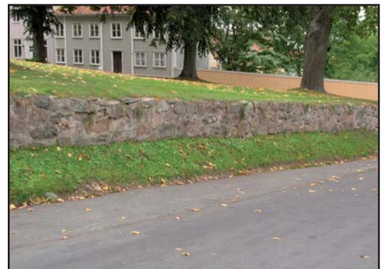
Mot Brahegatan fungerar kyrkogårdsmuren som en stödmur. Den har under senare tid fogats med cement.
