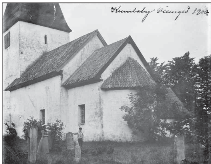
Kyrkogården 1900 med bibehållen ängskaraktär. Observera trävården till vänster. Fotograf: Otto Janse. ATA.
