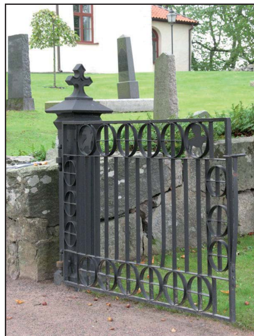
Ena södra grindhalvan med nygotisk gjutjärnsstolpe.
