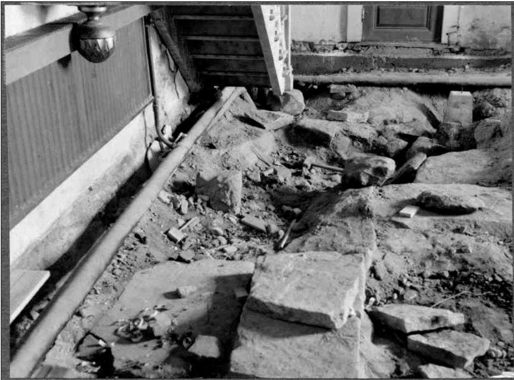
Bilden är tagen i samband med restaureringen 1938 och visar spåren efter den medeltida grundmurarna. Foto Egil Lönnberg 1938
