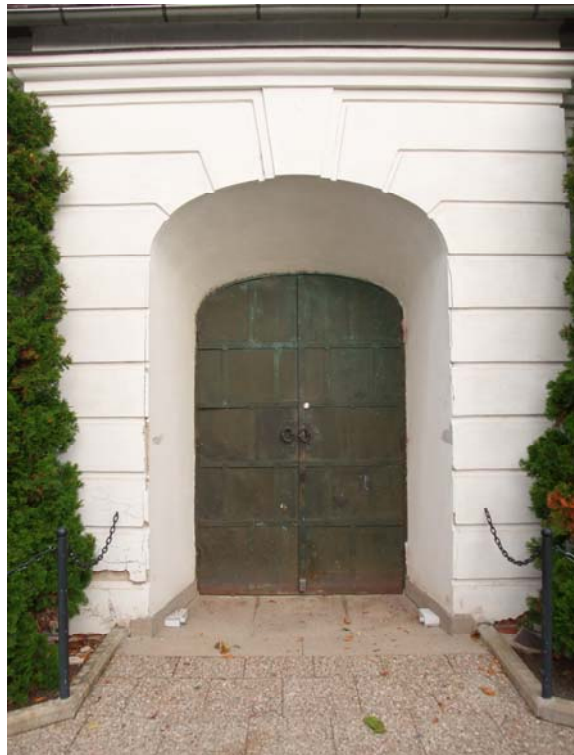
Den kopparklädda pardörren i entrén.
