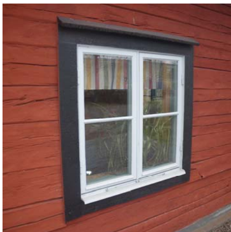
Ett av de kopplade fönstren.
