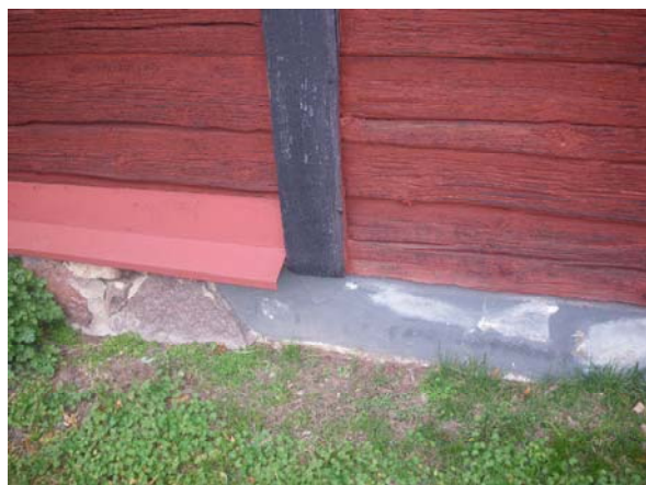
Naturstensgrund möter gjuten grund.
