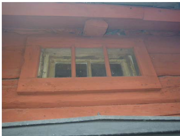
Ett av de små fönstren vid takfoten.
