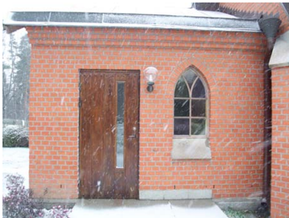
Tillbyggnadens sydöstra fasad.
