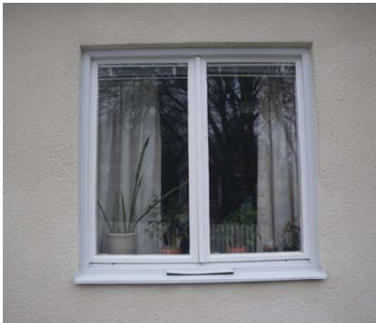
Fönsterbåge i bostadshuset.
