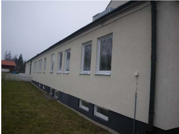
De administrativa lokalerna mot nordost. östvägg och i den lägre byggnaden.
