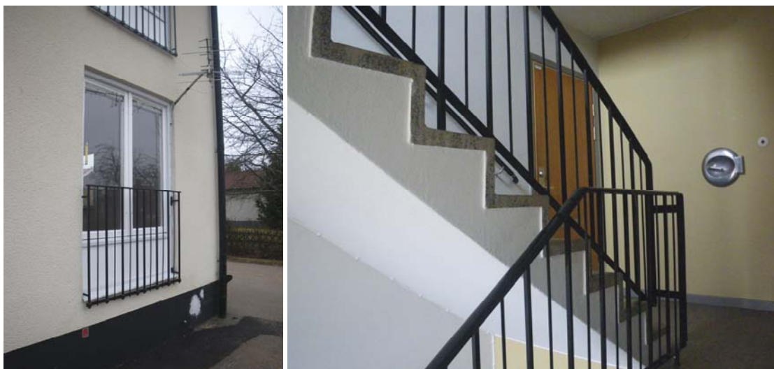
Vädringsbalkong på västra fasaden. Trappuppgång i bostadshuset.
