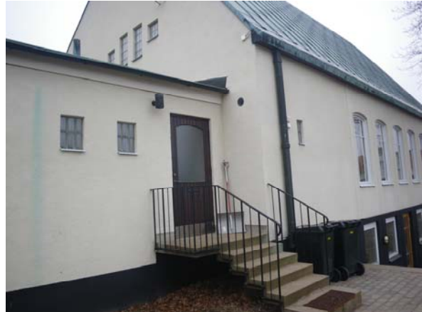
Entré mot norr. Betongglasfönster i kyrkans
