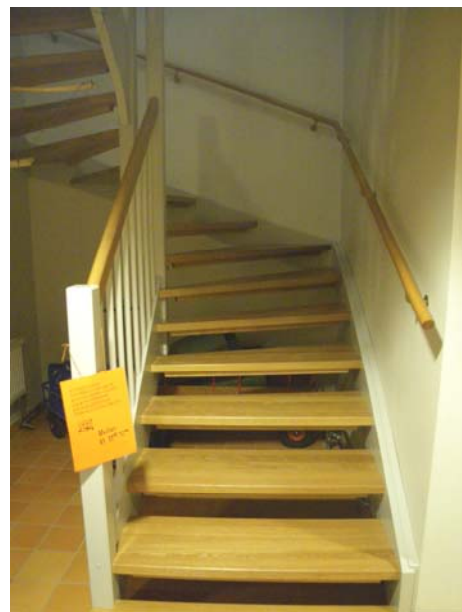
Trappa vid barnverksamheten mitt i byggnaden.
