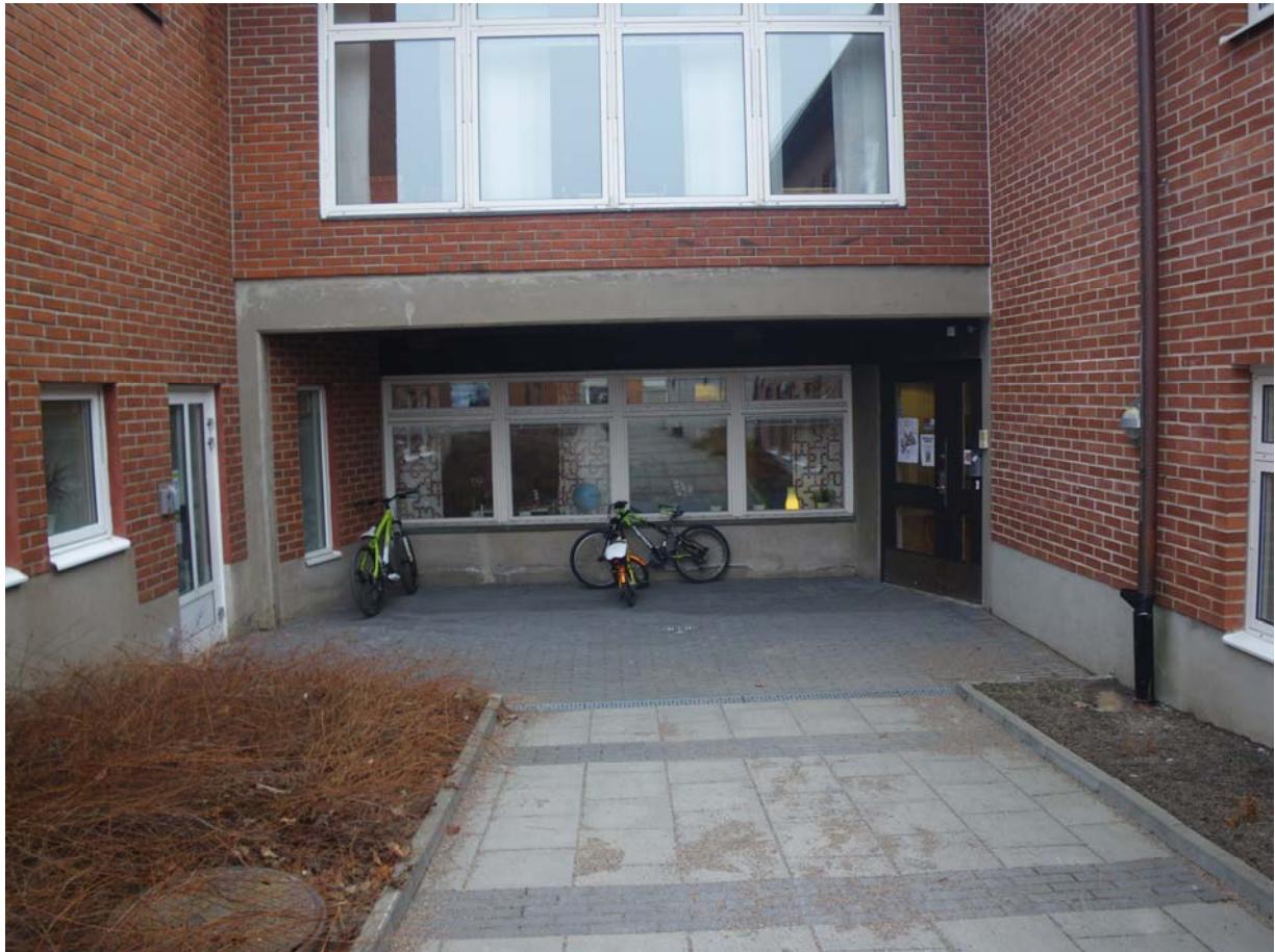
Entré till barnverksamhet i suterrängvåningen. Diakoniexpedition till vänster. Mot norr
