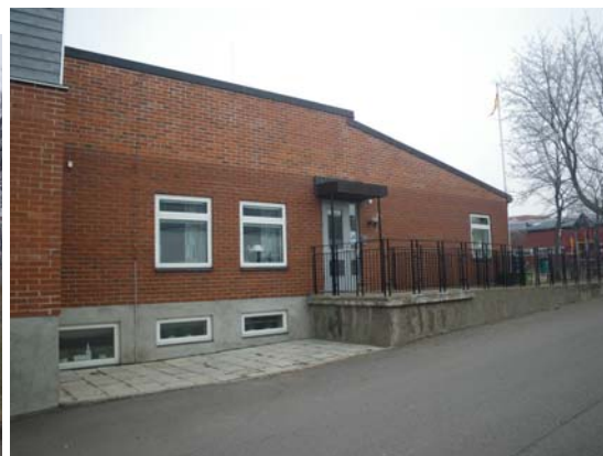
Entrén mot väster med ramp.
