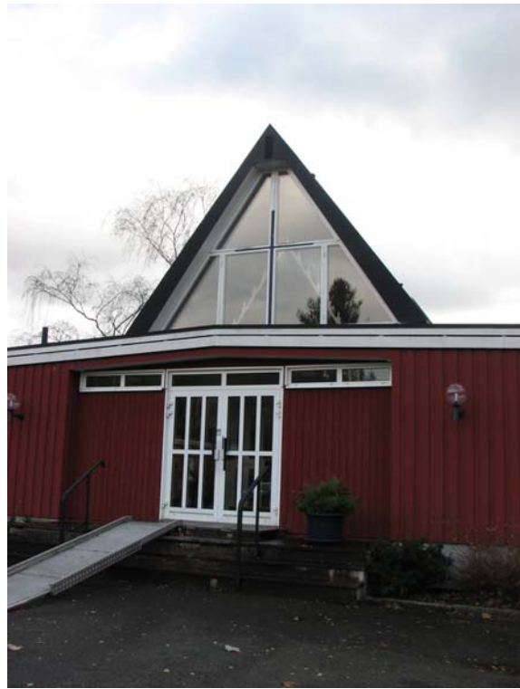
Västfasaden med huvudentré. Det västra gavelröstet är försett med stora öppningsbara fönster, original, på vars karm ett kors är målat i svart.
