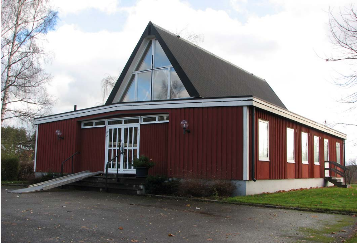
Storebro kyrka mot sydväst. Entré med betongtrappa, smidesräcke och entrédörrar av vitlackad aluminium.
