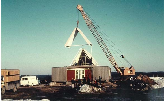
Kyrkan monteras i mars 1969. Monteringen utfördes under en dag. Foto: Vimmerby församling.
