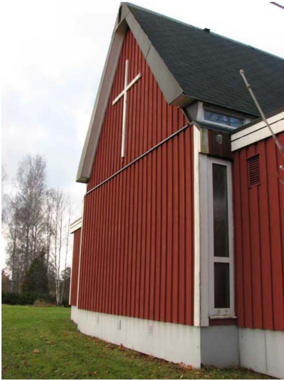
Östra fasaden med korfönster.
