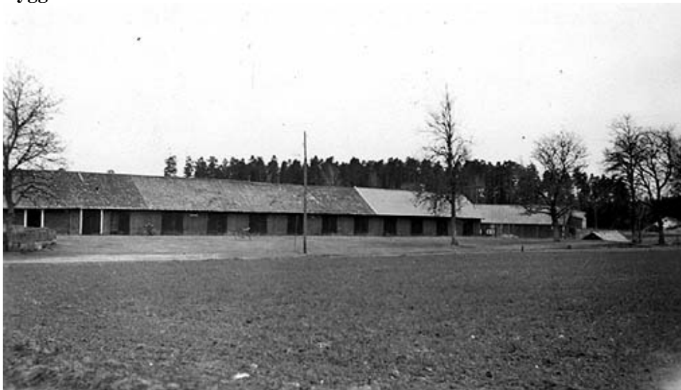
De västra kyrkstallarna i Ulrika. Idag är större delen av byggnaden riven då kyrkogården byggts ut i västlig riktning. Den västra delen av kyrkstallarna finns kvar och fungerar bl a som kyrkvaktmästarförråd. Bild från Östgotabild.
