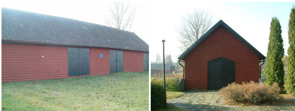
Det västra kyrkstallets norra fasad och östra gavel.
