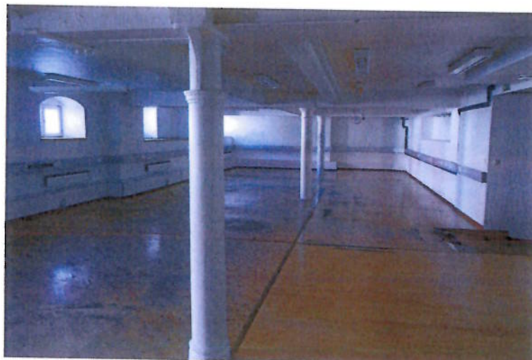
Källarplanet under längan mot Stationsgatan. Gjutjärnskolonner i bärlinan.
