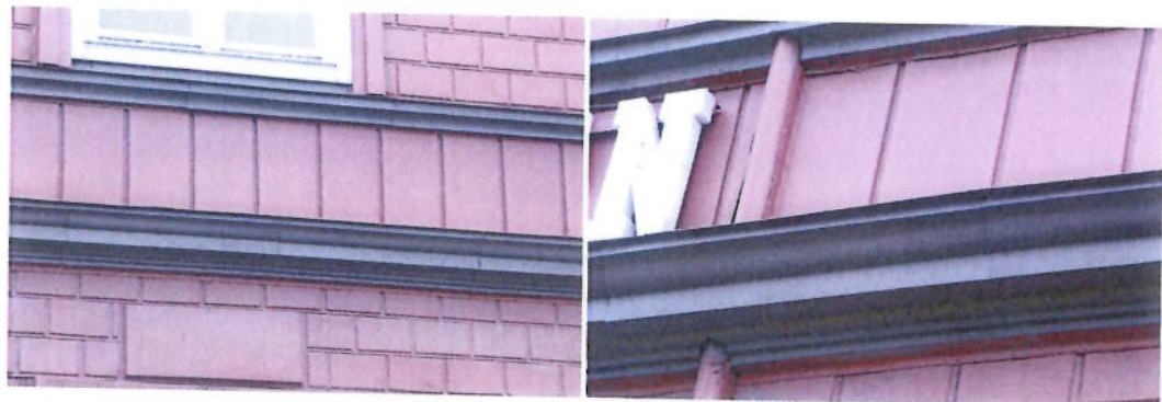
Detaljer av våningslisten med "rusticerat" mellanparti och sammansatta profiler i över- och underkant. Övre planets fönster är "ställda" direkt på listen.
