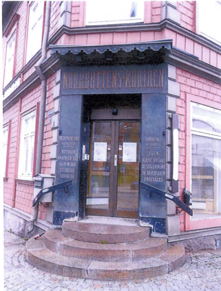
Entré från gatan – tidsenlig omfattning men moderna dörrar, Baldakin av 1930-talssnitt och ett skyltfönster som förstörades 1950, tidigare satt här ett vanligt fönster.
