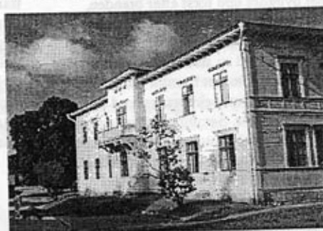
GAMLA JÄRNVÄGSSTATIONEN Fastigheten Hunden 1, byggt 1861 som järnvägsstation på banan Bergvik-Söderhamn.
