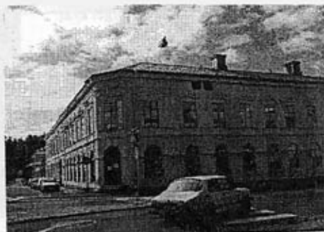
STADSHOTELLET Fastigheten Oxen 7, byggt 1879 av C Dahlgren.
