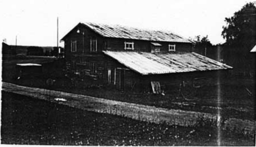
Torvalla 3:4. Ladugård, norra och östra fasaden
