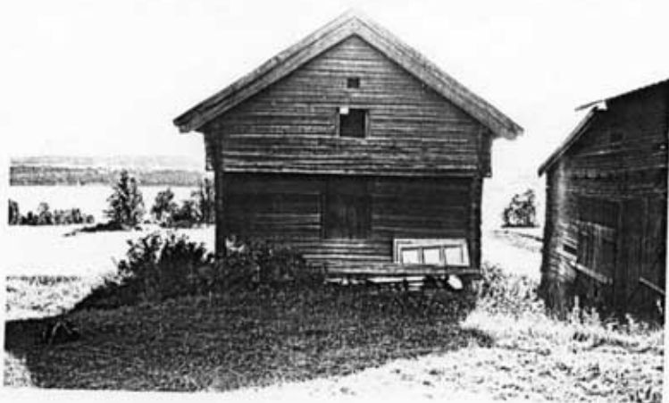
Torvalla 3:4. Hårbre, norra fasaden
