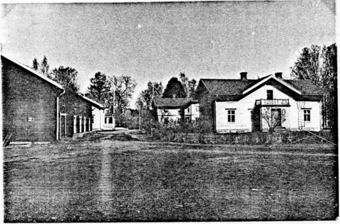
Anderstorps gård. T v magasinet och f d kontoret (byggnad b), t h bostadshus (c), i fonden huvudbyggnaden (a)
