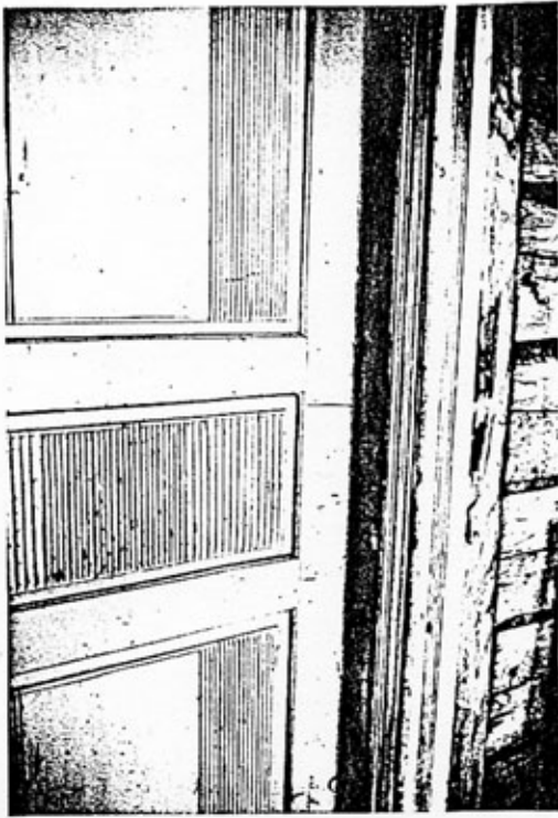
Härbyggnad I Detalj av dörr i kök mot N
