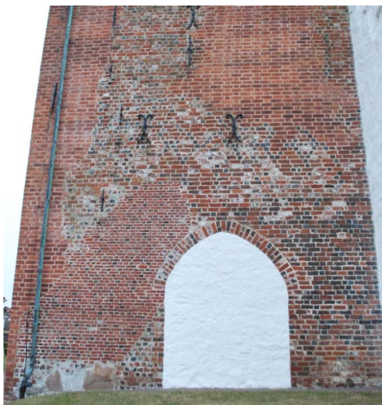
[2]: Södra tornfasaden med ommurade partier
