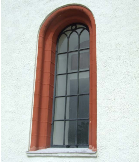
[1]: Långhusfönster med rödmålad omfattning
