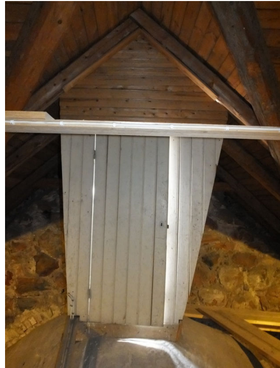
På vinden finns en inbyggnad för ett ljusschakt ned till koret. Ljusöppningen är numera igensatt ned till koret.
