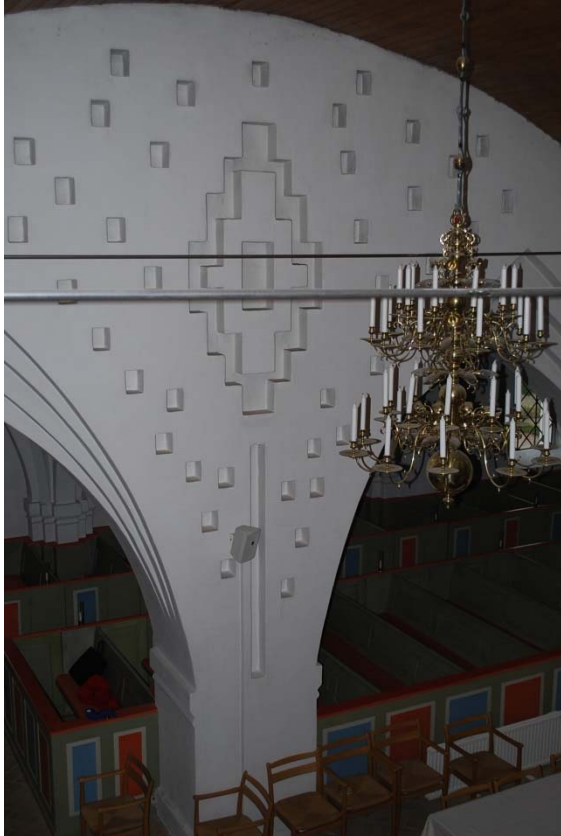
Muren mellan långhus och korsarm från orgelläktaren.
