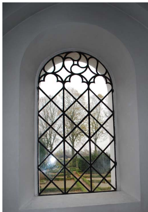
Fönster med gjutjärnsspröjs.
