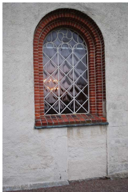
Gjutjärnsfönster och rester av tidigare portal.
