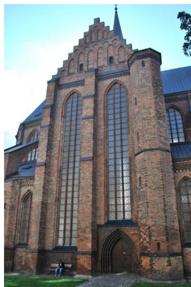
Fasad mot norr, tvärskeppet.
