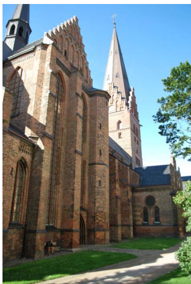
Fasad mot nordöst.
