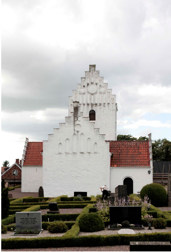
Kyrkan har flera medeltida trappstegsgavlar med möstermurade blindingar. Vapenhusets trappstegsgavel är mer sentida och tillkom vid Henrik Sjöströms restaurering 1905.
