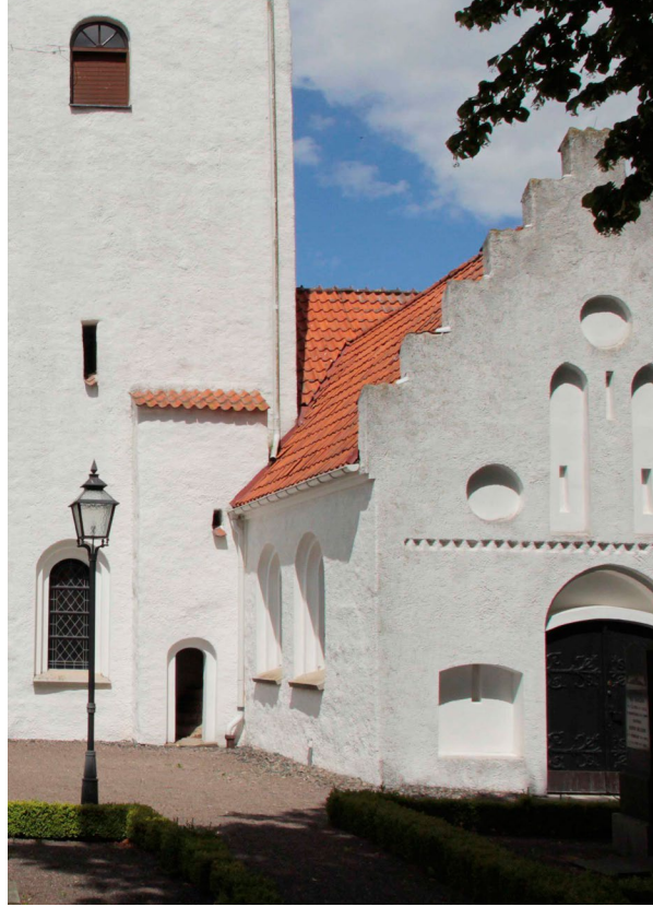
Kyrkan har flera medeltida trappstegsgavlar med möstermurade blindingar. Vapenhusets trappstegsgavel är mer sentida och tillkom vid Henrik Sjöströms restaurering 1905.
