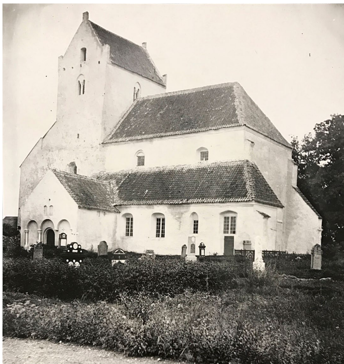
Kyrkan fotograferad 1877. De vita skällningarna längs tegeltakens kanter skvallrar om att taken var understrukna. (ATA)
