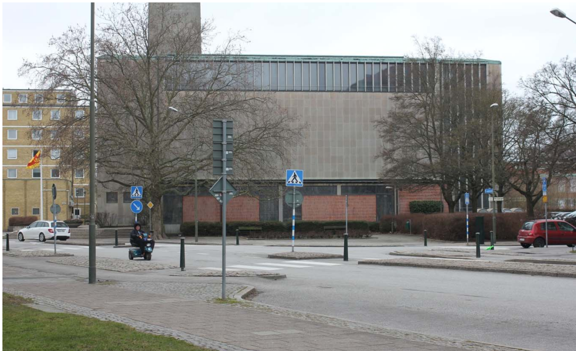
[3]: Fasad mot öster med lägre kapelldel
