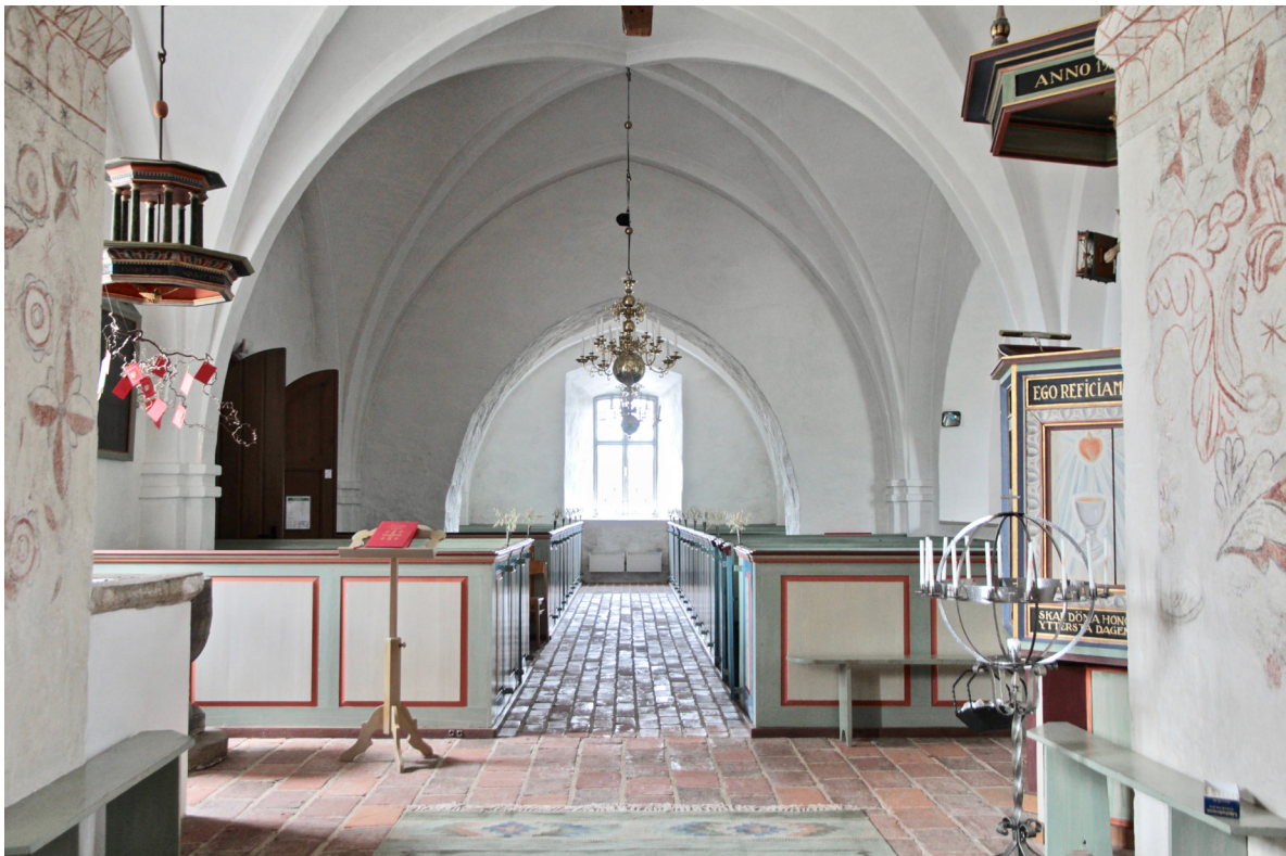
Långhusets västra del avgränsas av en spetsbågig valvbåge och utgörs av det tidigare tornets bottenvåning.
