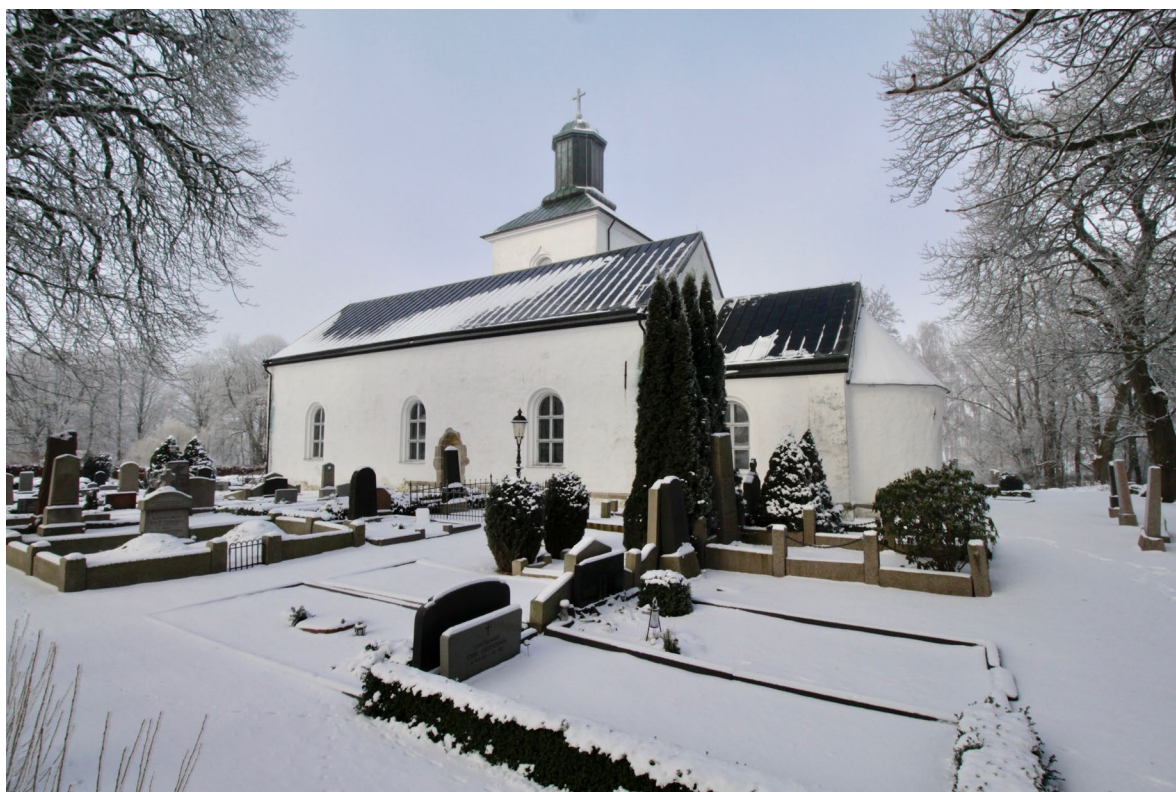
Kyrkan från sydost. Centralt på långhuset syns den ursprungliga sydportalen.
