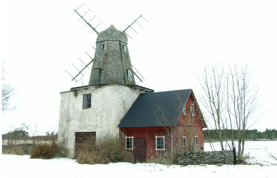
Foto före restaureringen 2008-2009. Pär Malmros, Gotlands Museum.
